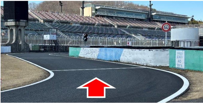
① ピットレーン入口 (資料1項)
