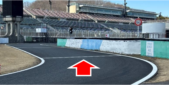
① ピットレーン入口 (資料1項)
