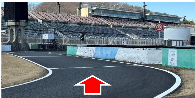
① ピットレーン入口(資料1項)
