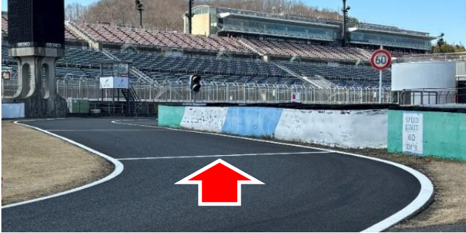
① ピットレーン入口 (資料1項)
