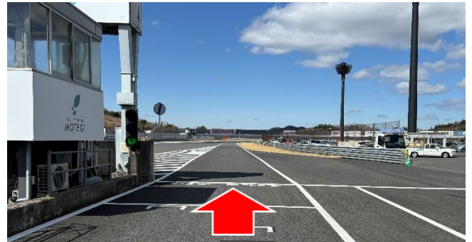
②ピットレーン出口(資料1項)
